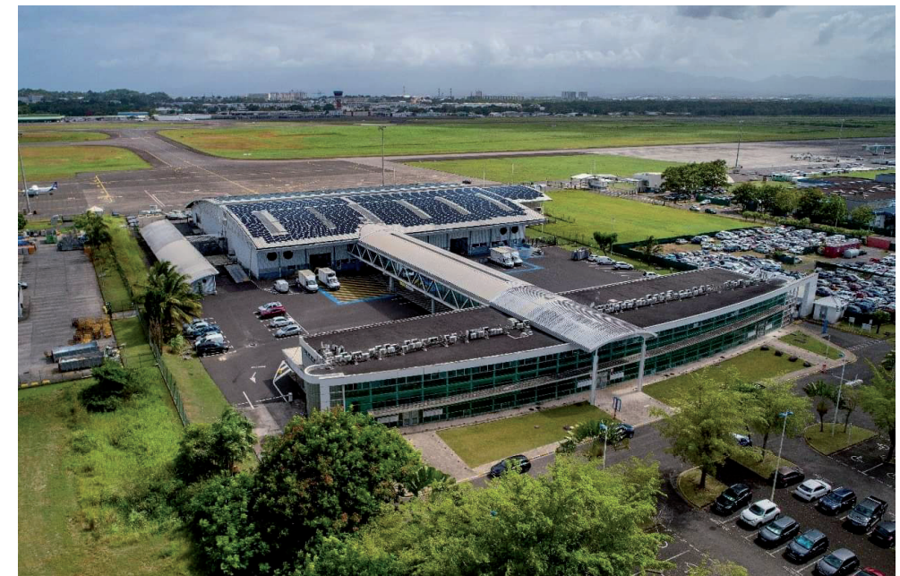
Installations photovoltaïques pour l'autoconsommation Source : ADEME, Urbasolar
