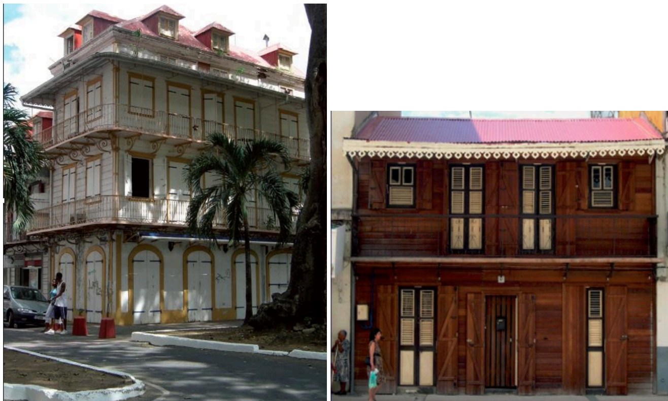
Figure 15 Bâti patrimonial typique du centre ancien de Pointe-à-Pitre, avec balcons en fer forgé et maison de ville (source : Atlas des paysages de l'archipel Guadeloupe)
