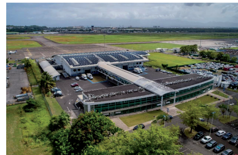
Installations photovoltaïques pour l'autoconsommation
