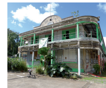
Ancien bâtiment administratif d'usine Darbousier - Pointe-à-Pitre
