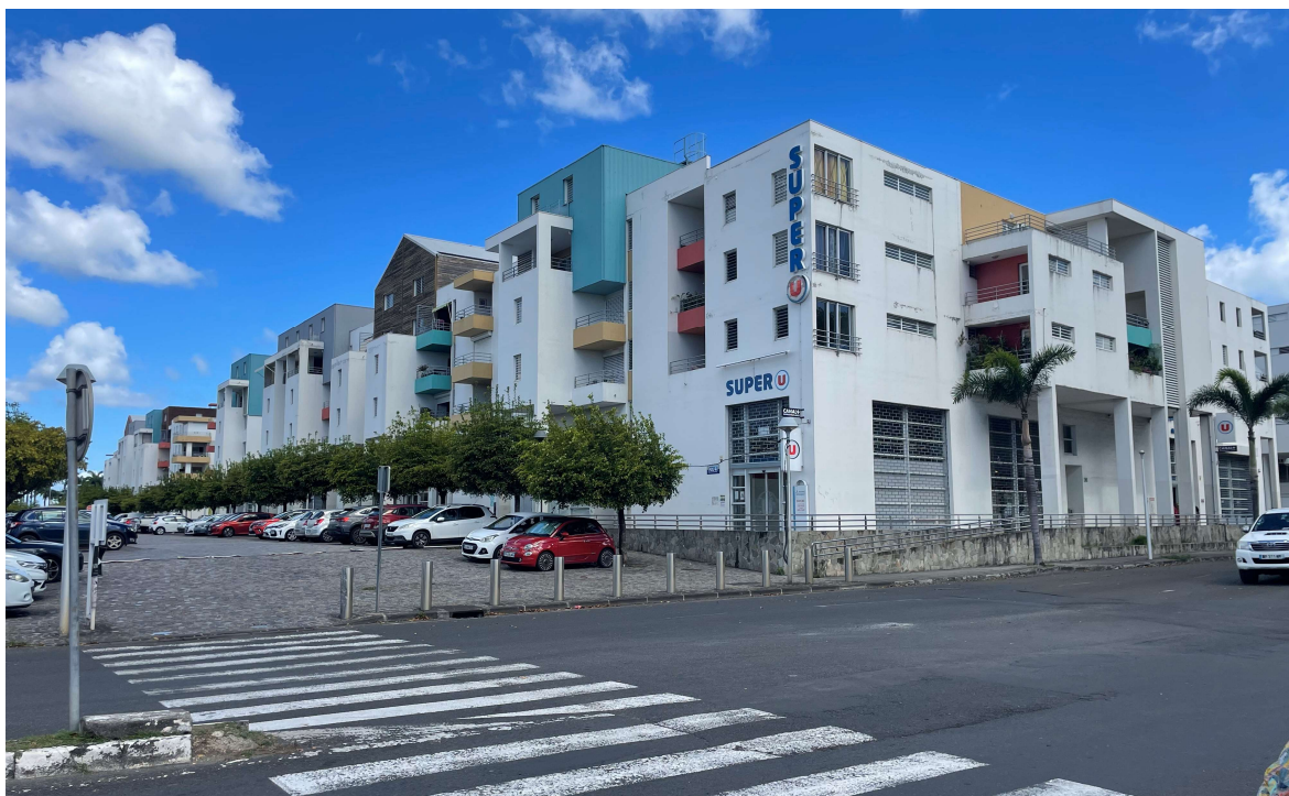
Figure 68 : Résidences et parking à l'ouest du quartier (Source : FILAO Ingénieurs Conseils)
