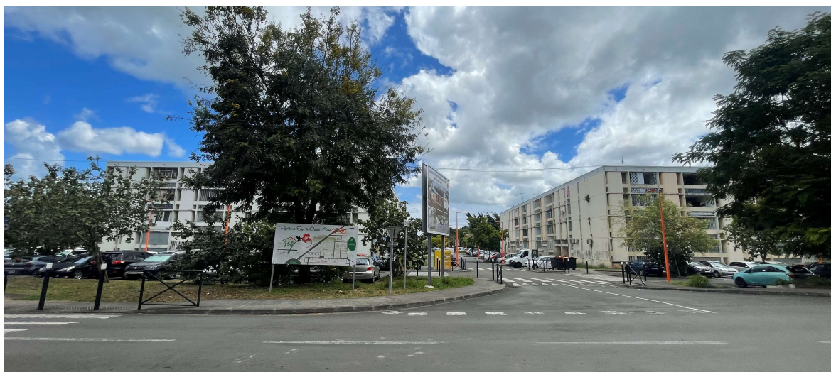
Figure 62 : Vue depuis le Nord de la parcelle vers le Nord-Est. Source : FILAO Ingénieurs Conseils
