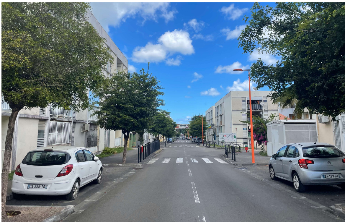
Figure 61 : Rue des capitaines prise du sud en regardant vers le nord. Source : FILAO Ingénieurs Conseils
