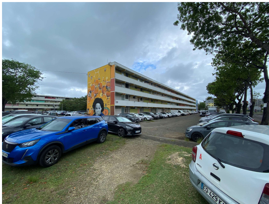
Figure 96 : Immeubles résidentiels et zones de stationnement vus de la route (Source : FILAO Ingénieurs Conseils)
