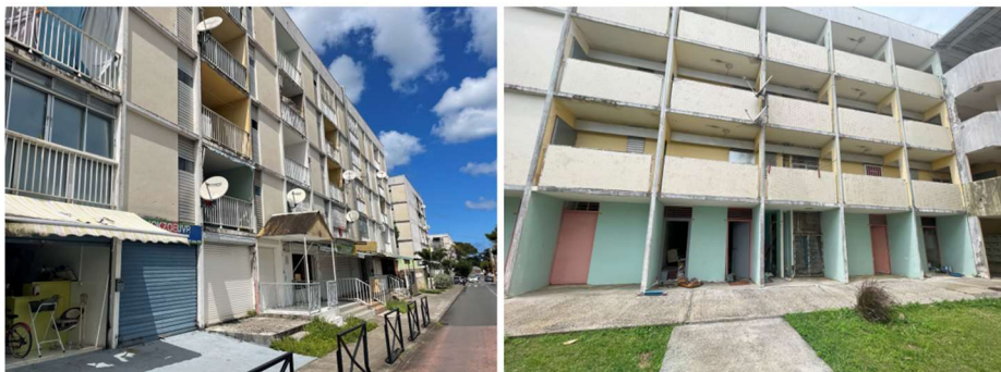
Figure 87 : Logements présents au nord du quartier du Morne. Source : FILAO Ingénieurs Conseils
