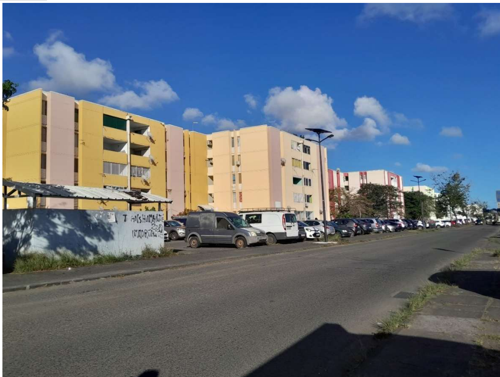
Figure 81 : Immeubles aux alentours de la Gabarre (Source : FILAO Ingénieurs Conseils)
