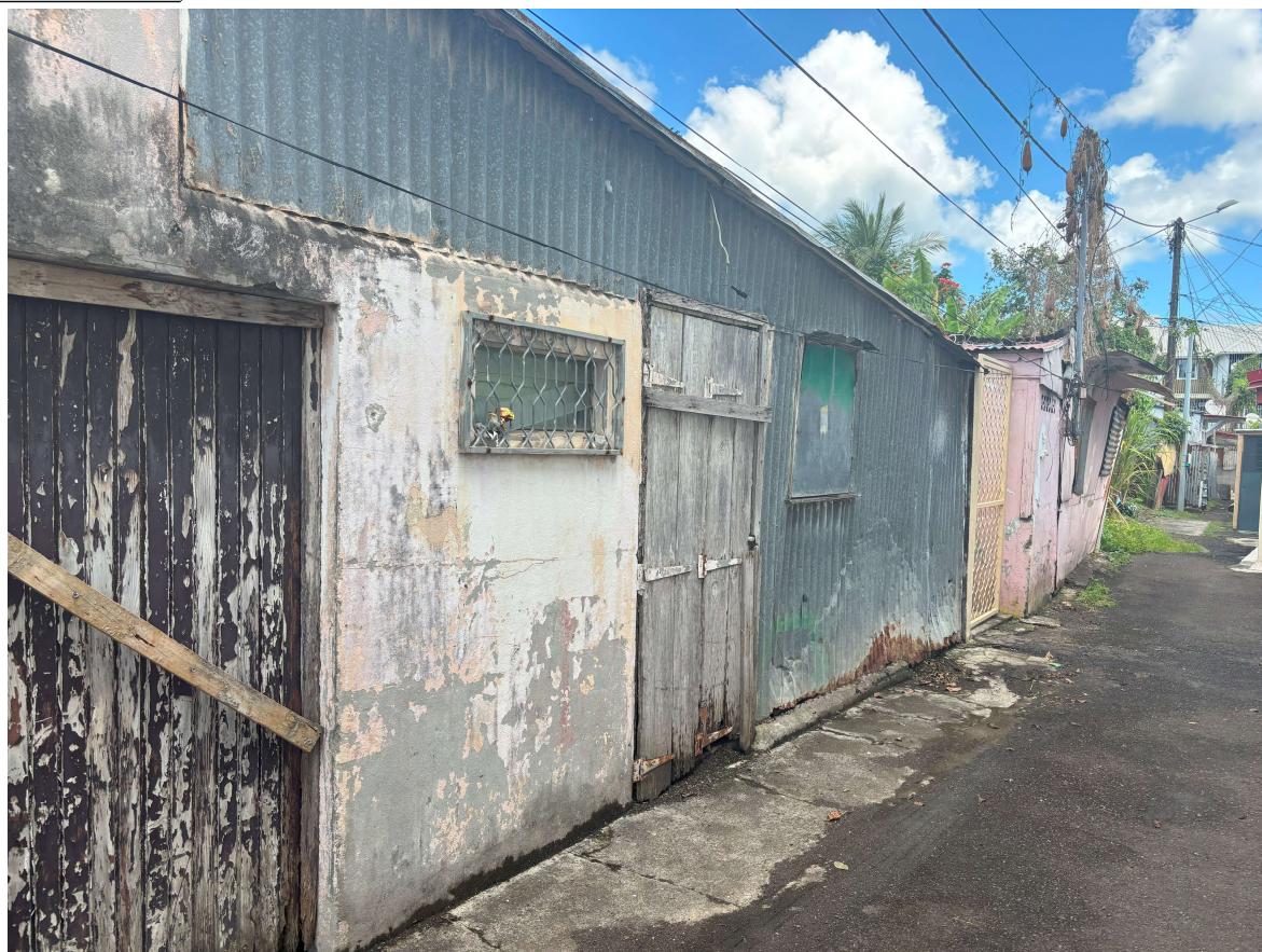
Figure 101 : Vue sur les habitations individuelles du quartier de Vieux-Bourg (Source : FILAO Ingénieurs Conseils)
