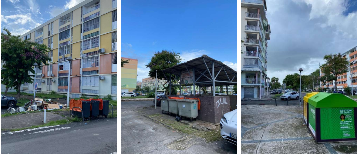
Figure 145 : Infrastructures en place pour la collecte des déchets sur le quartier de l'Hôtel de ville (Source : FILAO Ingénieurs Conseils)
