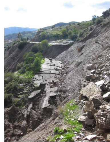
Figure 15 : Schéma conceptuel du phénomène de glissement de terrain (à droite) et glissement en bordure de l'Oued Nekor, au Maroc (à gauche) [Source : IMSRN]
