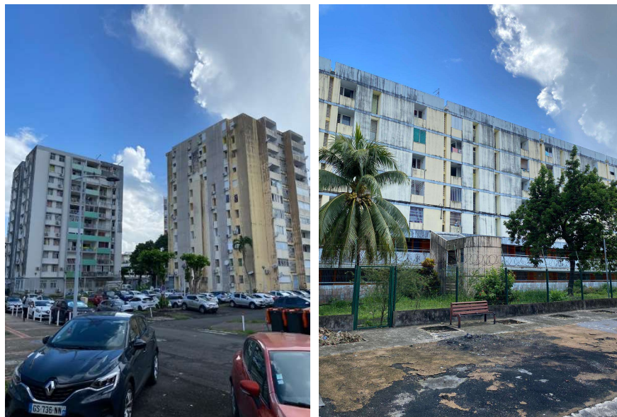
Figure 19 : Bâtiments résidentiels bordant le quartier à l'ouest et au sud (Source : FILAO Ingénieurs Conseils)
