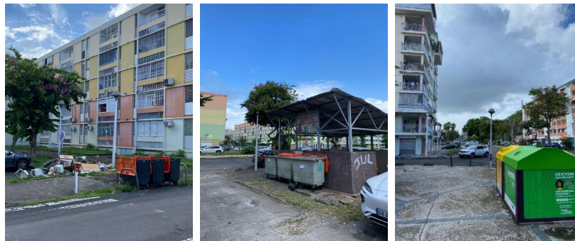
Figure 33 : Infrastructures en place pour la collecte des déchets sur le quartier de l'Hôtel de ville (Source : FILAO Ingénieurs Conseils)
