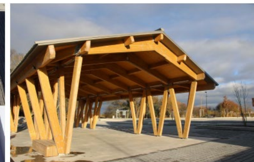
Carbet, point de rassemblement visible
