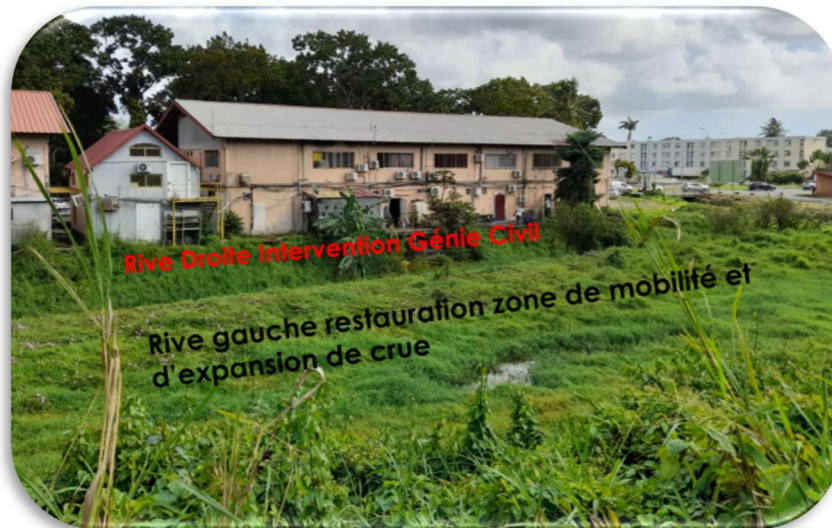
Figure 3 - Photographies de la zone de restauration en rive gauche
