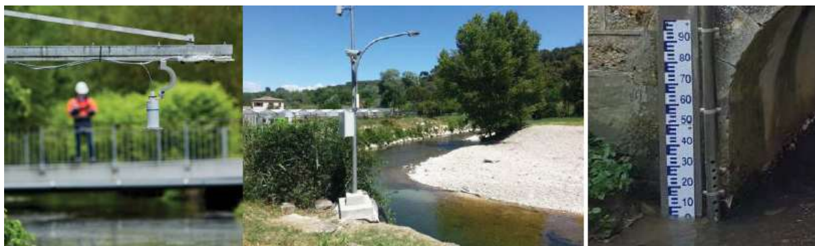
Figure 2 - Exemple des équipements à déployer
