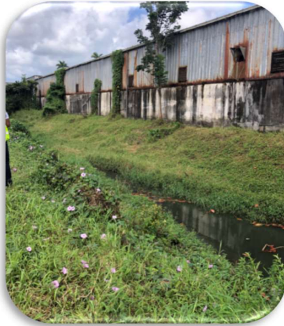
Figure 2 - Photographies de la berge rive droite nécessitant une stabilisation par du génie végétal et/ou du fascinage
