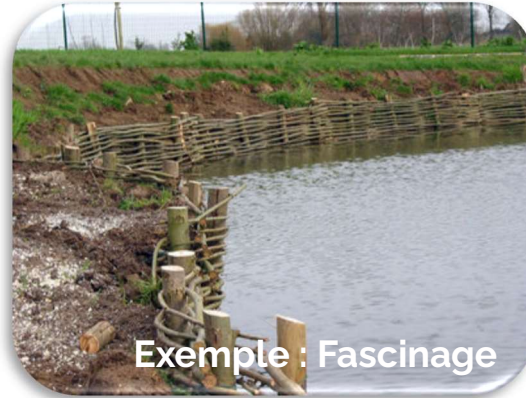
Figure 2 - Photographies de la berge rive droite nécessitant une stabilisation par du génie végétal et/ou du fascinage
