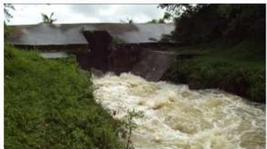
Figure 7 - Ouvrage écrêteur de crue de Petit-Pérou
